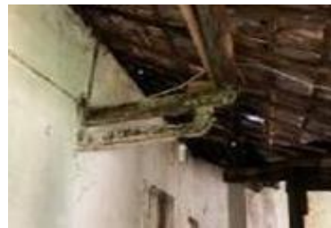
Gambar 7. Rangka atap bagian belakang bangunan
