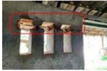
Gambar 6. Dinding bagian belakang bangunan
