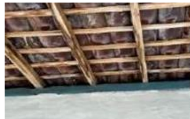
Gambar 8. Rangka atap bagian depan bangunan
