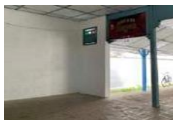
Gambar 5. Dinding bagian dalam bangunan
